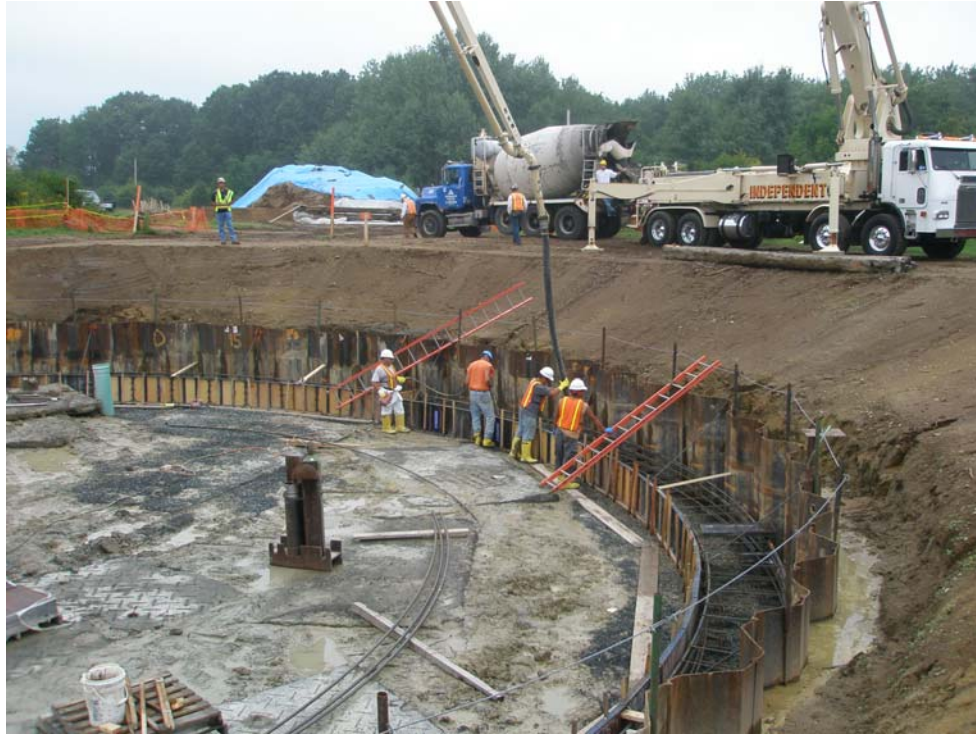
Photograph 3 – Beginning Stages of Concrete Pour
